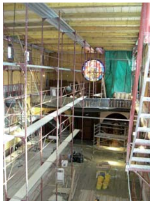
Echafaudages dans l'église
