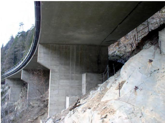
Comme tous les ouvrages d'art de la vallée, le viaduc routier de Finhaut était miné de façon à pouvoir couper les axes de communication. Ces ouvrages sont généralement très discrets. Ici il n'est matérialisé que par deux petits cubes de béton adossés contre la première pile de l'ouvrage.
