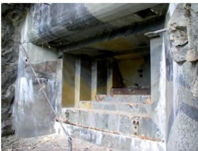
Détail d'une embrasure pour mitrailleuse au Fort de Litroz. Le camouflage peint directement sur la masse couvrante du béton date de la seconde guerre mondiale. Il a été amélioré plus tard par l'installation de treillis de camouflage.
