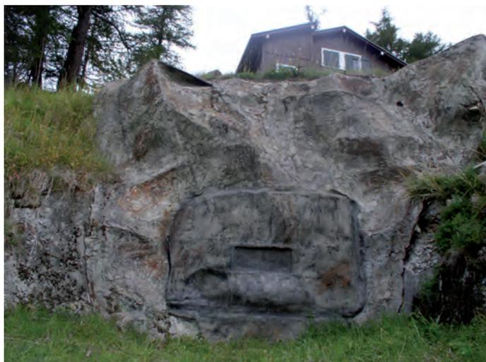
Ce faux rocher situé sur le col de La Forclaz dissimule en réalité l'embrasure d'un redoutable canon antichar pointé sur l'axe Chamonix - Martigny. Le chalet visible au second plan correspond également à un ouvrage militaire.
