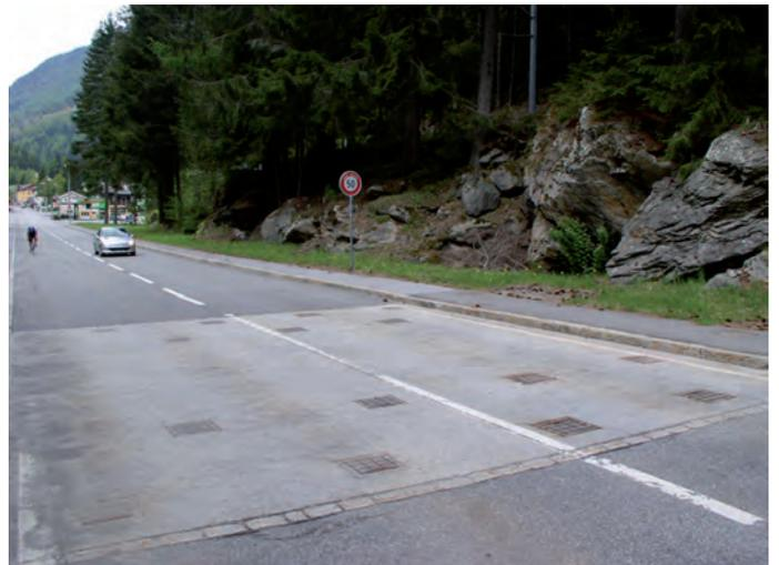
Barricade antichar établie au niveau de Châtelard-Frontière. On distingue clairement les couvercles des puits destinés à recevoir les poutrelles d'acier permettant de couper l'axe routier.
