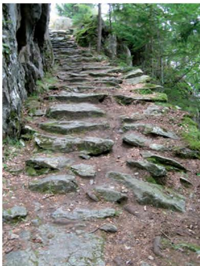
Figure 6: Marches aménagées pour faciliter le passage du bétail entre les Marécottes et la Crettaz du Trétien.
