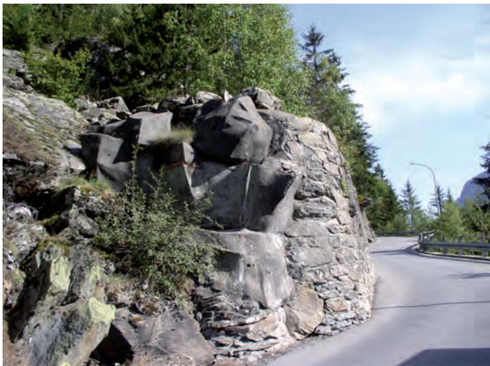
Vue frontale du fortin installé sur la route de Châtelard-village. Le camouflage en faux rocher dissimulait un canon antichar qui prenait en enfilade la barricade et le poste frontière de Châtelard. Cet ouvrage a été détruit en 2009 pour permettre l'élargissement de la route, dans le cadre du projet Nant de Dranse.
