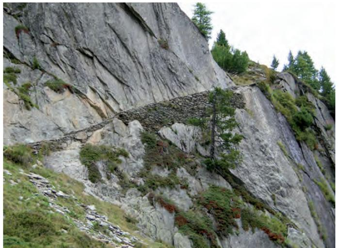
Figure 5: Impressionnant mur de soutènement bâti pour accéder à l'alpage des Grands.
